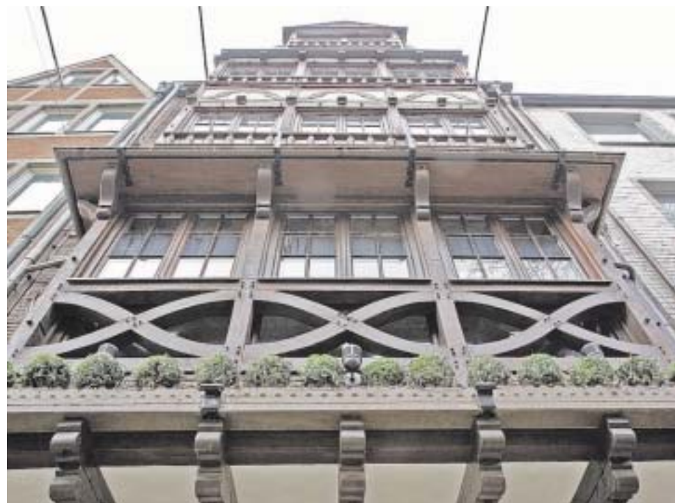
Der Hühner-Hugo nach der Sanierung der Fassade an der Bolker Straße - so sah das Lokal schon vor 80 Jahren aus.
